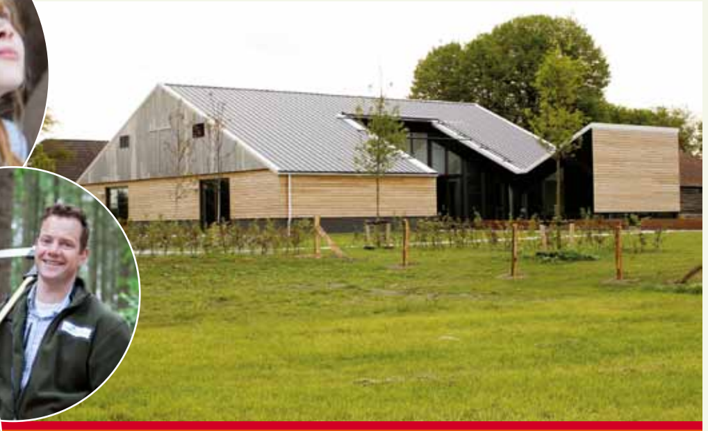
Informatiecentrum aan de Wechelerweg 52b
